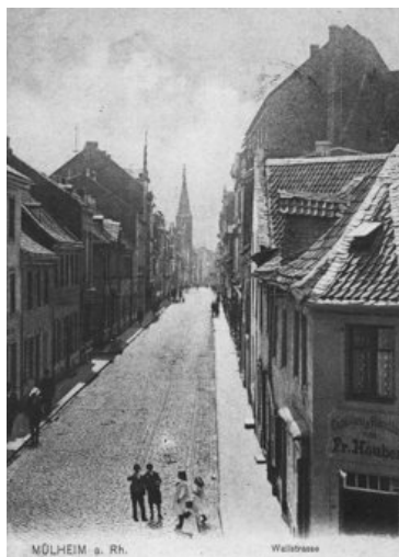
Wallstraße ab Freiheit vor Errichtung der Gaststätte „Steinförte“, 1910
