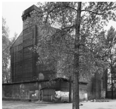
Bunker Berliner Straße 20, ca. 1975
