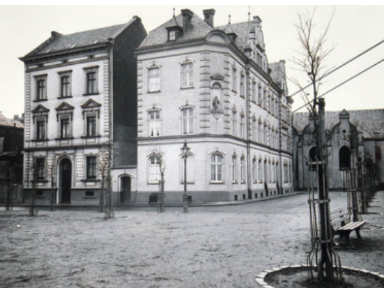
Kohlplatz mit Kaplanei und St. Clemens, ca. 1931
